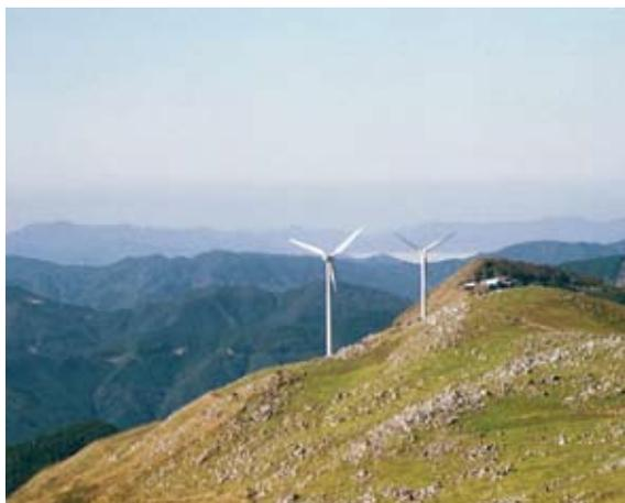
平成11年、ここに町が設置した風力発電の風車が2基あり、ともに高さ約50m、長さ25mのプロペラが回っている。それぞれ600kwの発電能力があり、経費を差し引いても年間3,500万円前後の売電収益がある。
