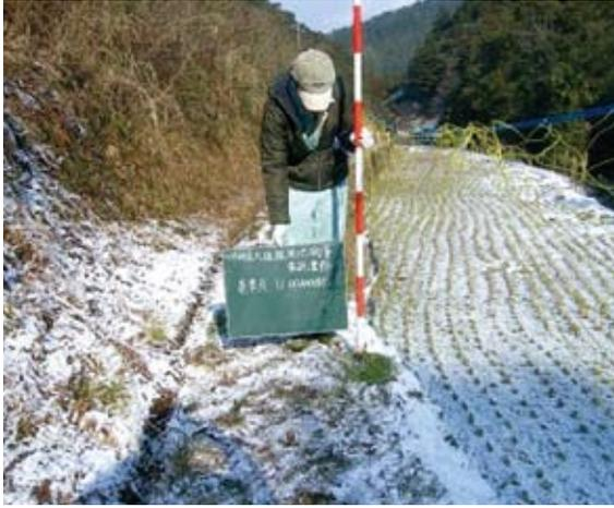
発見した与点を基準に、多角測量を行い新規の準拠点（金属釘）を設置する。
