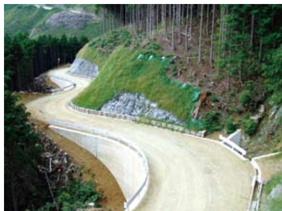
寒風大座礼西線 1 工区工事
