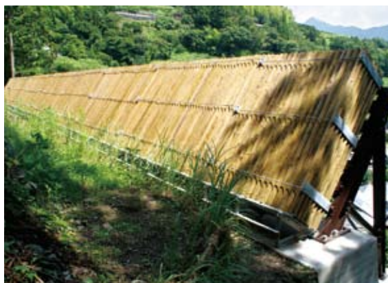
中村林地荒廃防止工事
