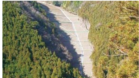
中尾谷復旧治山工事
