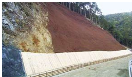
森林基幹道開設事業小川線工事
