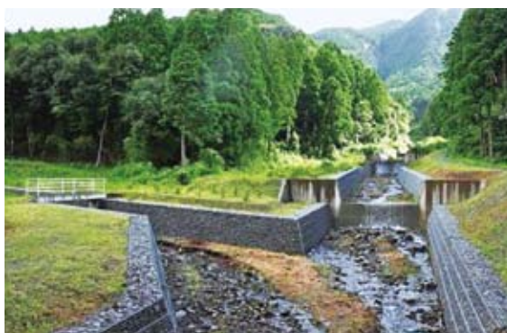
中の川林地荒廃防止工事
