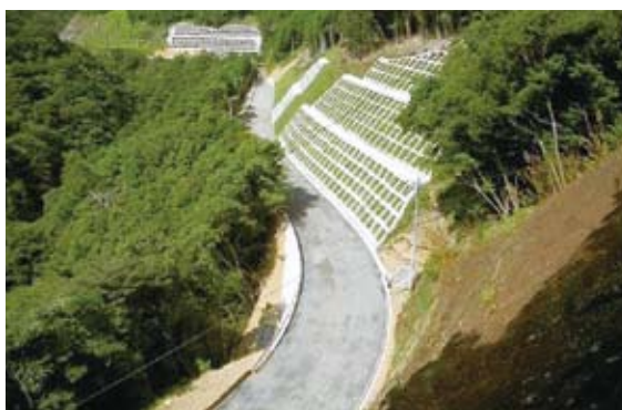
山のみち地域づくり交付金事業 清水・三原線 2 工区工事
