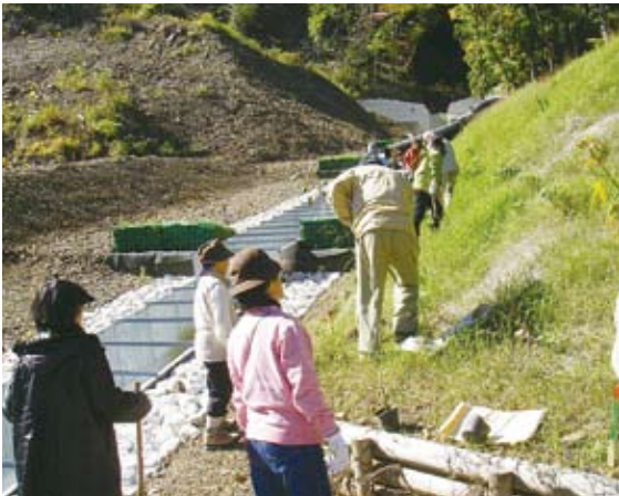
植樹作業状況
