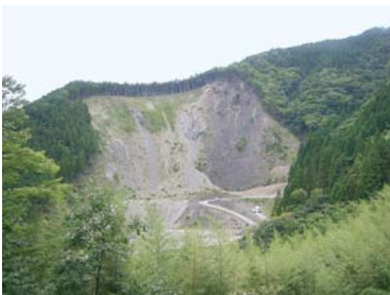
上部崩壊状況
