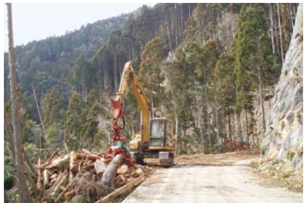
2 工区搬出状況
