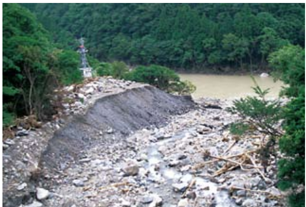
(写真－14) 奈半利川との合流点に堆積する流出土砂（小島地区）
