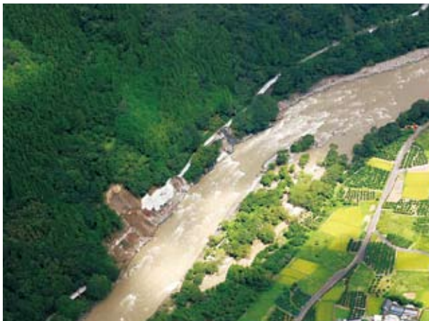
(写真－4) 国道・小島キャンプ場の被災状況
