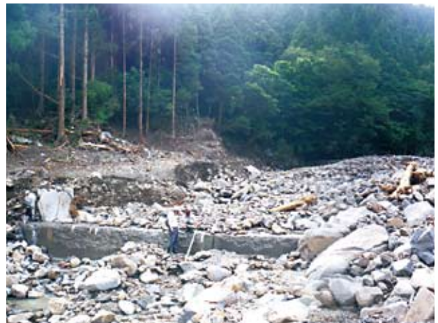
(写真－9) S.56年治山ダムの抑止効果(埋設状況)
