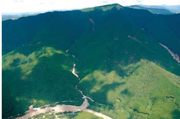
(写真－1) 小島地区全景
