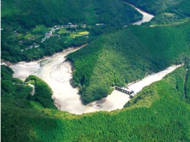
(写真－6) 平鍋地区の被災状況
