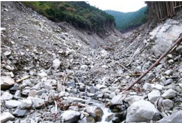
(写真－19) 平鍋地区の浸食状況
