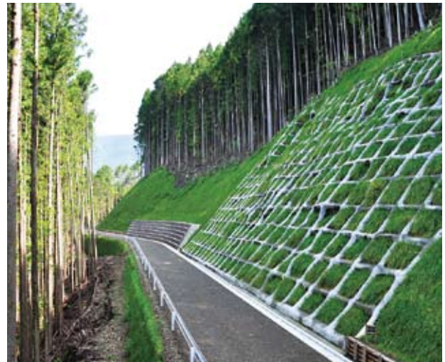
河口落合線 1 工区（補正）工事
