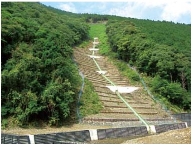
小馬場 NO.6 復旧治山工事
