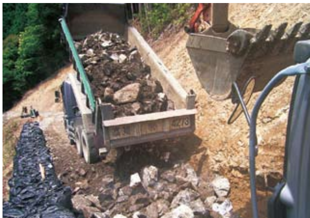
設置された大型土のうと路盤材搬入状況
