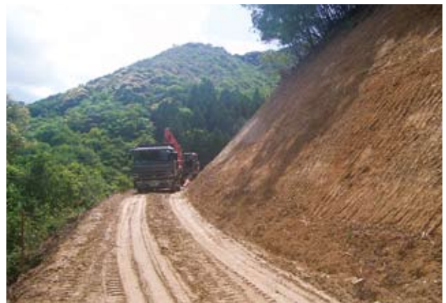
タイヤ跡が凹となった路面
