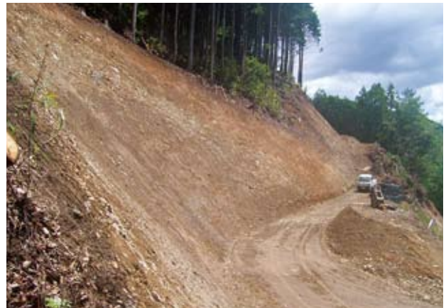
工事が進む作業道
