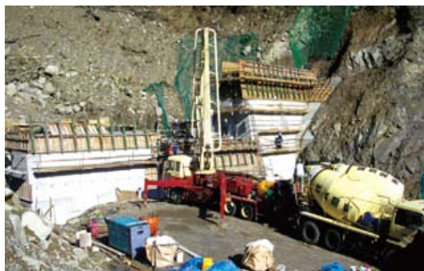
治山ダム本堤
