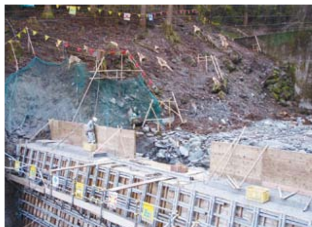
治山ダム施工中（大川村中切）
