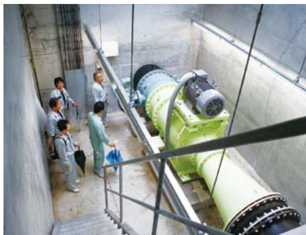
小水力発電施設
