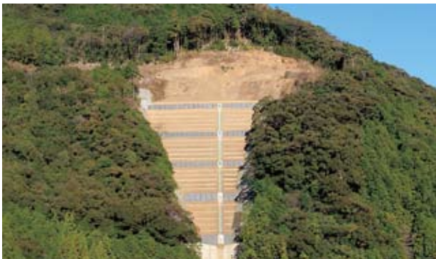
勝賀瀬復旧治山工事
