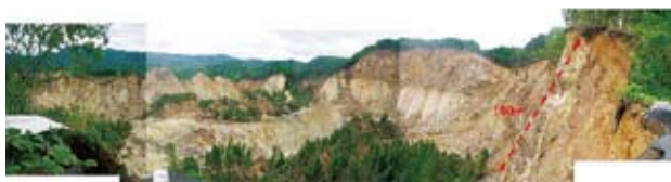
写真3 地滑りにより生じた冠頭部の凹地
