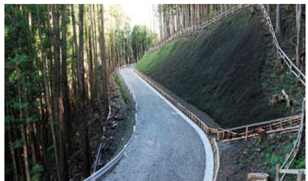
河口落合線 3 工区工事
