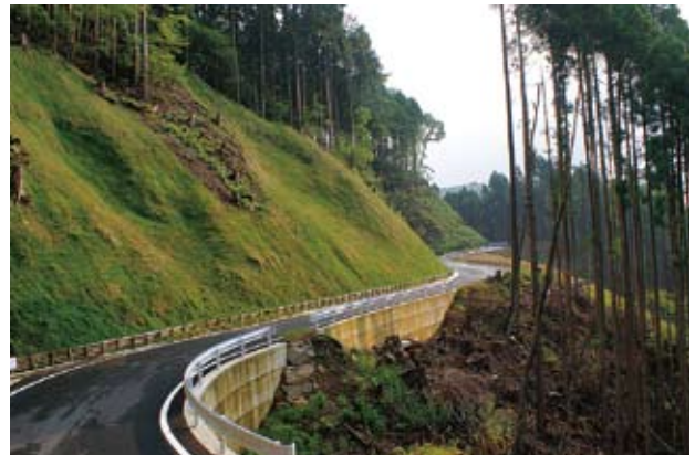
西谷朝日出線 2 工区工事
