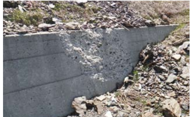
H25.4.15 物部町ヒカリ石 被災状況（土留工）
