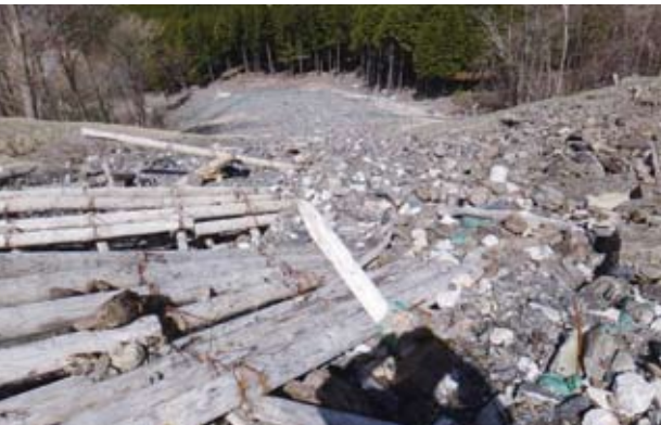
H25.4.15 物部町ヒカリ石 被災状況（柵工）
