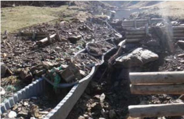
H25.4.15 物部町ヒカリ石 被災状況（水路工）
