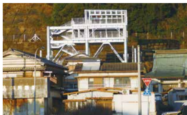
津波避難タワー（黒潮町佐賀）
