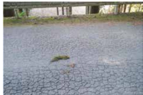
写真1 路面に見られる亀甲型キレツ
