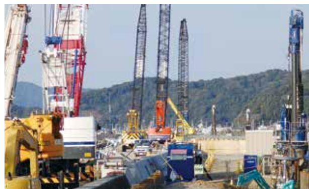
土佐市新居海岸の防波堤工事
