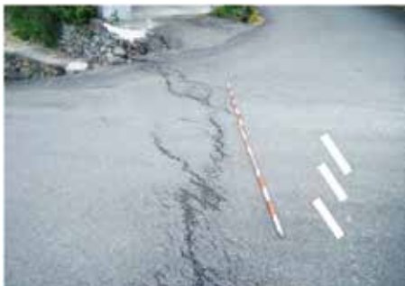
写真3 道路を横断するミの字型キレツ
