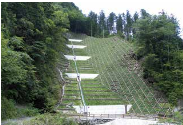
大川（加集）水源森林再生対策工事
