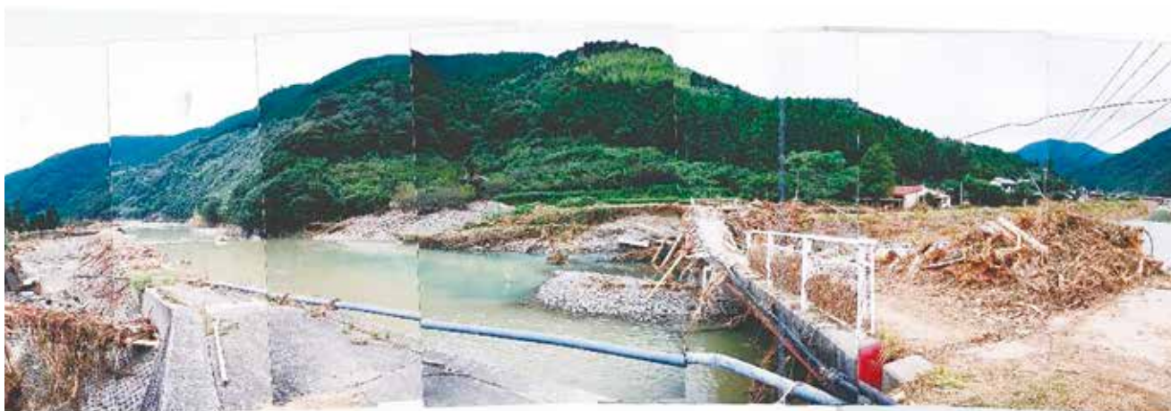
宗呂川流域被災状況②
