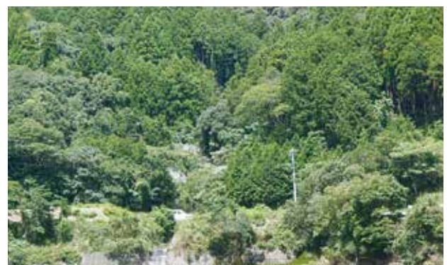
堤長60mほどの谷止工。県道からは目立たない。
