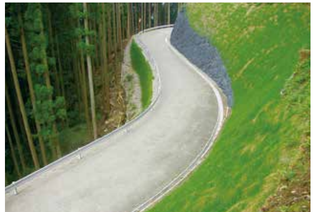
土居柳野線 2 工区工事
