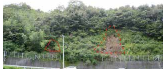
写真1 地すべり斜面全景 (赤破線区域が崩壊部)
