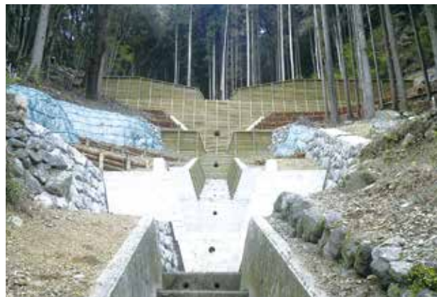
島中林地荒廃防止工事
