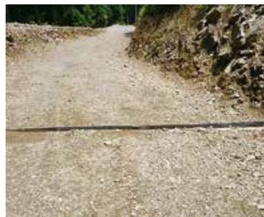
(現地間伐材 2 本を路面に埋設しスィエースと呼ばれる強度の強いゴム板を使用した横断溝)
