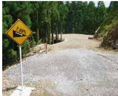
(従来の凹凸タイプで使用してきた流用土は路面が洗掘されやすいことから、耐久性を確保するため再生骨材を使用した敷き固めによる土構造)
