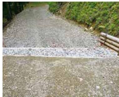
(現地間伐材で箱型の横断溝を作設し、レキ石を詰めた横断溝)
