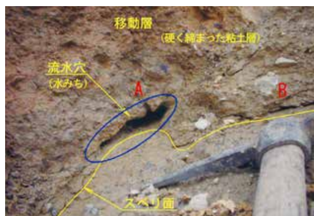
写真.2 スベリ面に見られる流水穴
