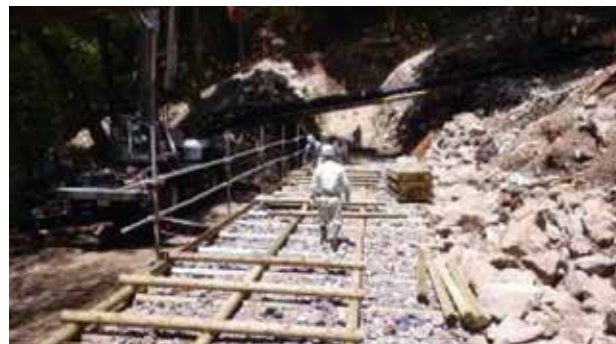
施工中の木製治山ダム
