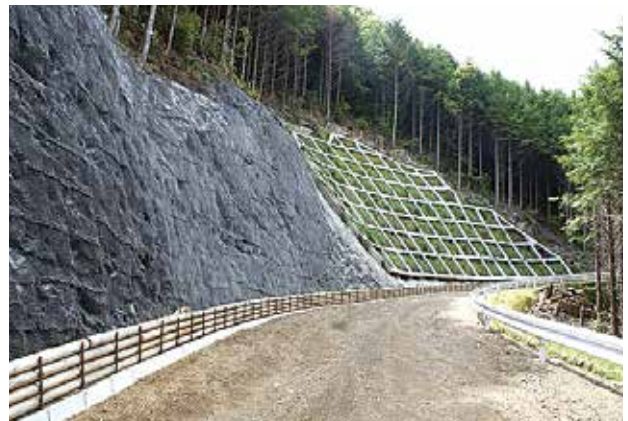
畑山仲木屋線 1 工区工事
