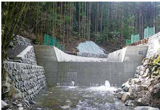
井崎林地荒廃防止工事
