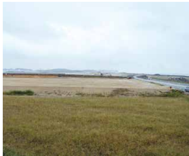
植生基盤盛土
