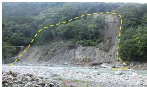
写真2 河岸を末端とする崩壊（奈半利川沿い）
