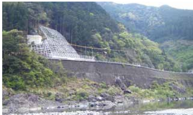
写真1 斜面途中を末端とする崩壊（仁淀川沿い）
