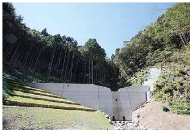
弘瀬復旧治山工事
