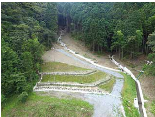
坂ノ川林地荒廃防止工事
