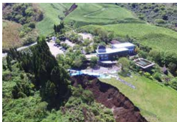
施設災害復旧箇所
