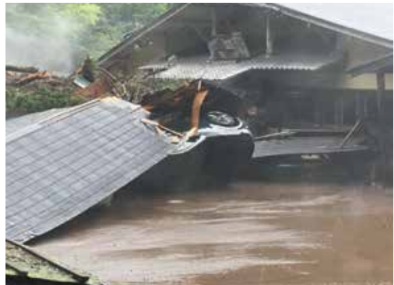
阿蘇地域 温泉旅館 被災状況
