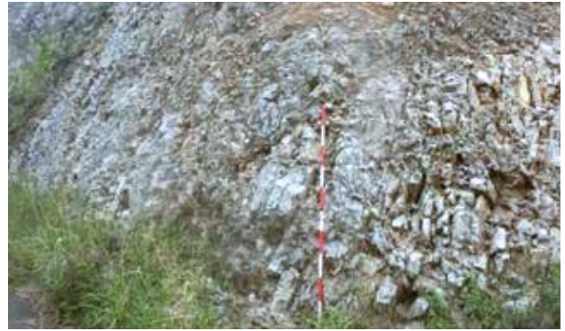
写真3 縦方向の割れ目が卓越する石灰岩
