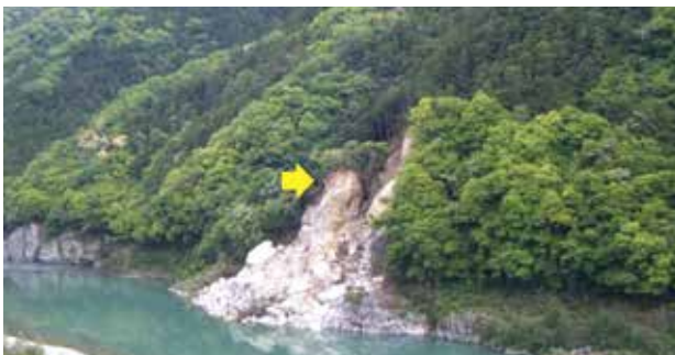
写真2 写真1地点の崩落後（柱状岩塊を形成）
