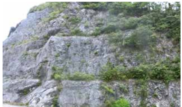
写真4 石灰岩のり面の産状（縦キレツと滑落）
