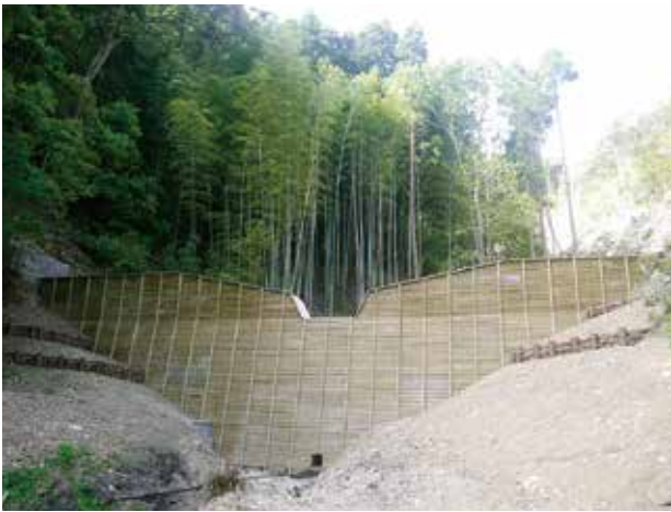
広瀬林地荒廃防止工事
