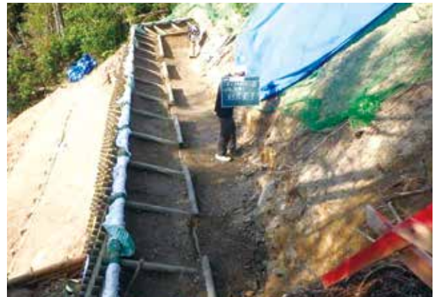
枠組上部埋戻状況
