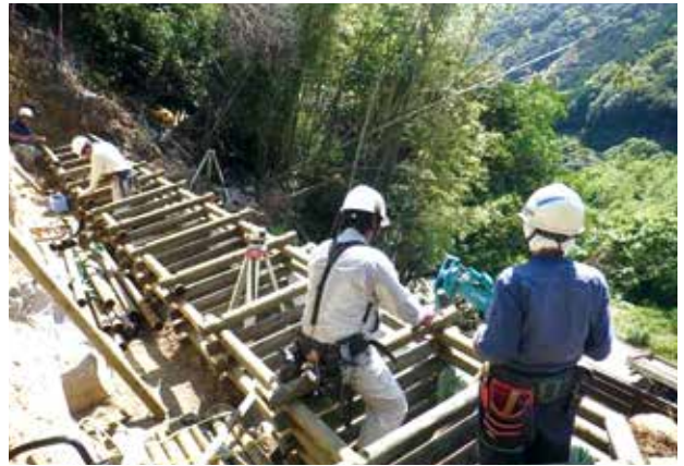
枠組上部施工状況
