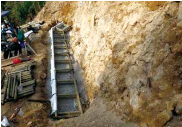
枠組 1 段目施工状況
