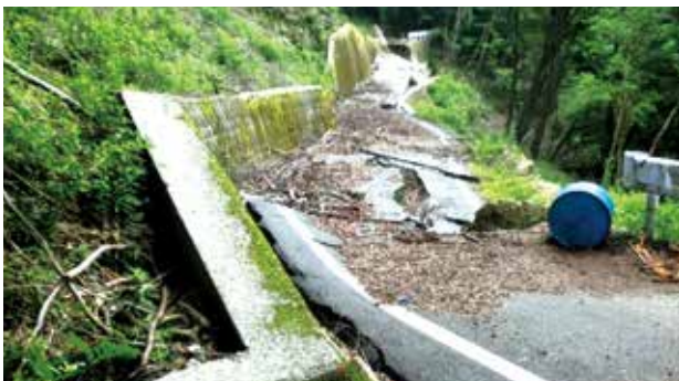
写真3 被害状況（終点側から起点側方向）
