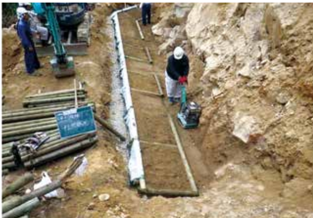
土砂埋戻転圧状況
