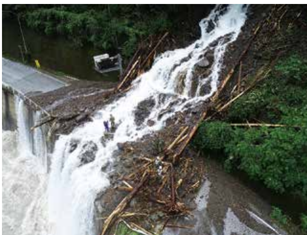
写真5：国道195号線榎山トンネル付近
