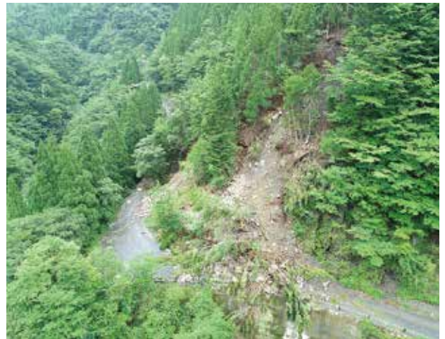
写真6：林道大栃線の崩壊状況
