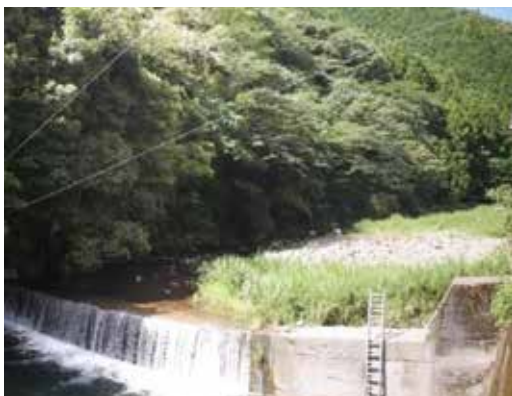
写真 6. 山腹工事箇所の現況（平成 30 年）
