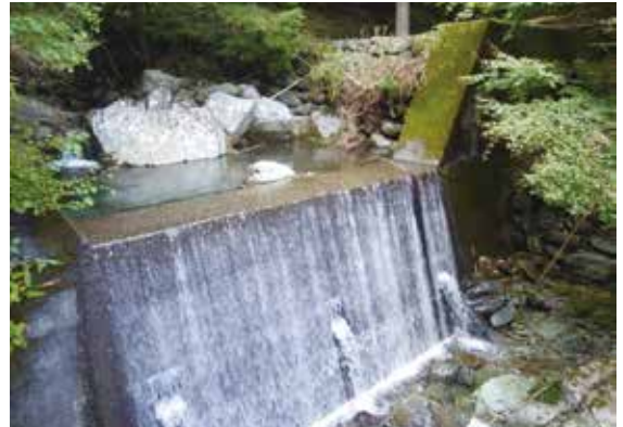
写真 7. 溪間工事箇所の現況（平成 29 年）
