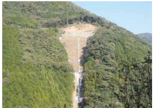
写真3. 山腹工事の完成時
