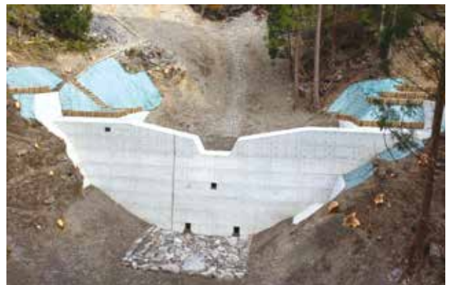
写真4. 溪間工事の完成時
