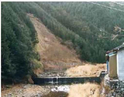
写真 5. 山腹工事箇所（昭和 55 年）
