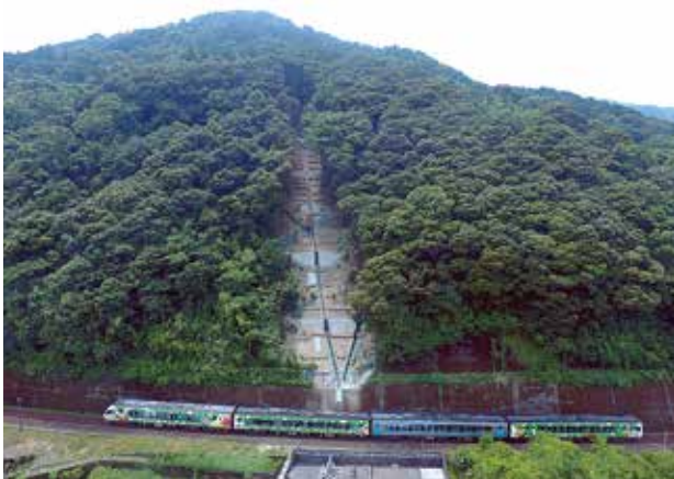
横浜林地荒廃防止工事
