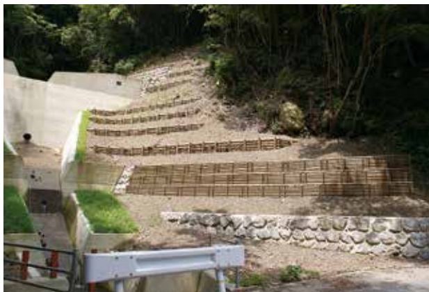
久保川 No.4 林地荒廃防止工事
