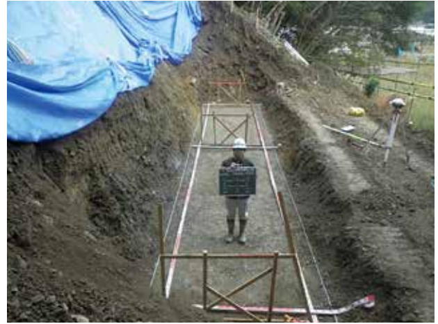
段階確認の様子
