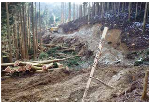
写真3 開設中の林業専用道
