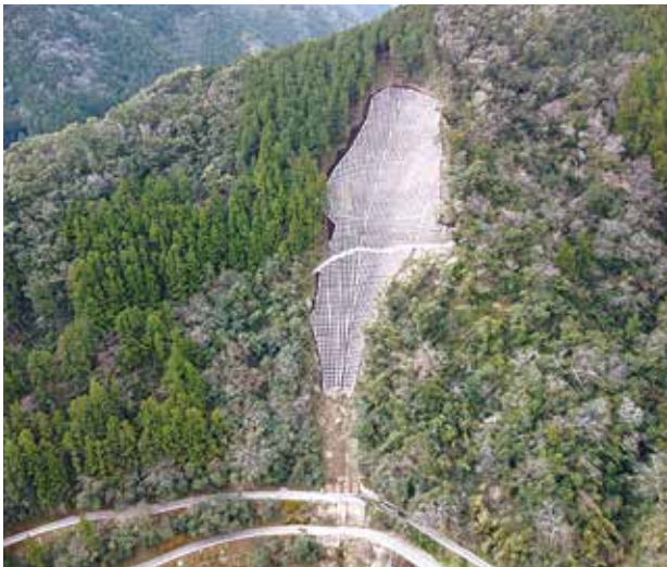
鏡横矢災害関連緊急治山工事
