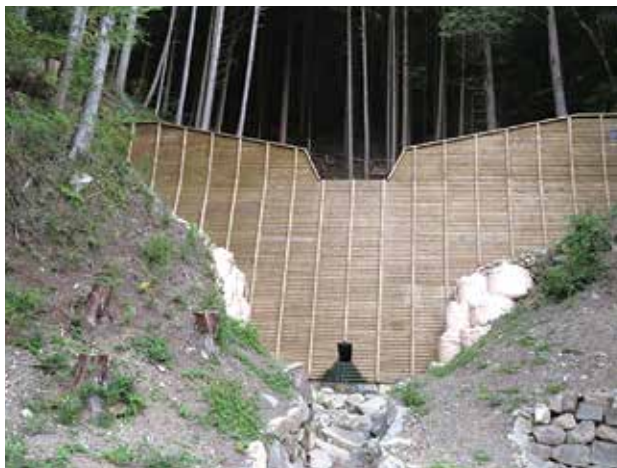
大正北の川林地荒廃防止工事
