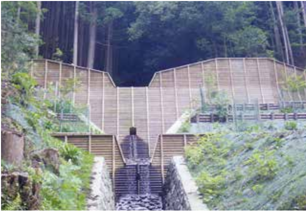
里川林地荒廃防止工事
