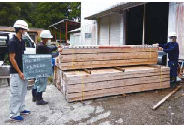
材料確認の状況
