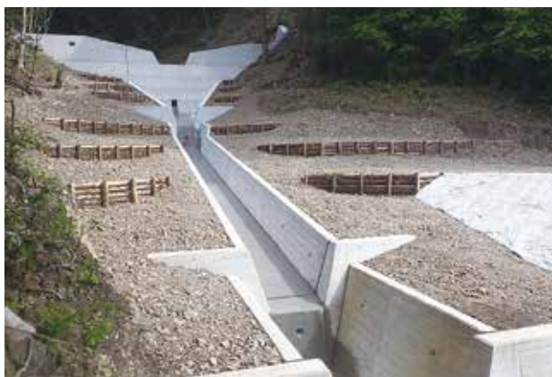
福良山地災害防止工事
