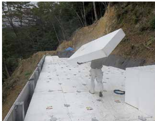
EPS 施工状況
