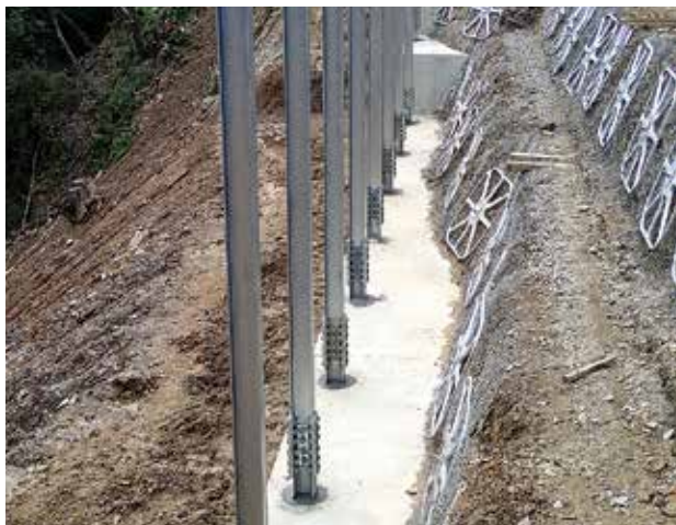
支柱設置完了
