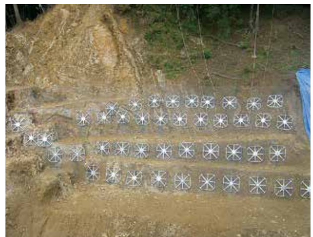
鉄筋挿入工完了
