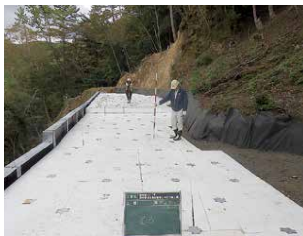
EPS 完成（引続き上部施工予定）
