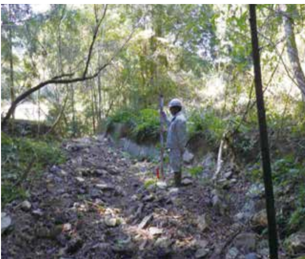
既設谷止工により堆砂敷を形成している
