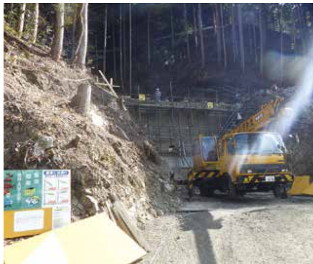
北ノ川林地荒廃防止工事
