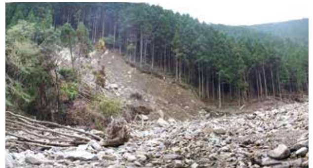
小島地区 S.52 堰堤工上流堆積状況
