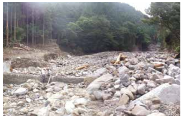
S.53 堰堤工 堤高 8.0m
