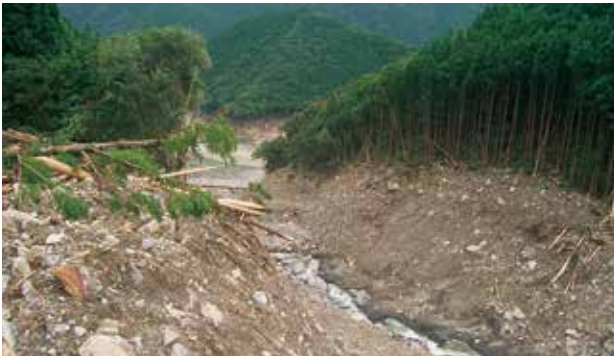
奥に見えるのが平鍋ダム。溪流を横断する国道が流失
