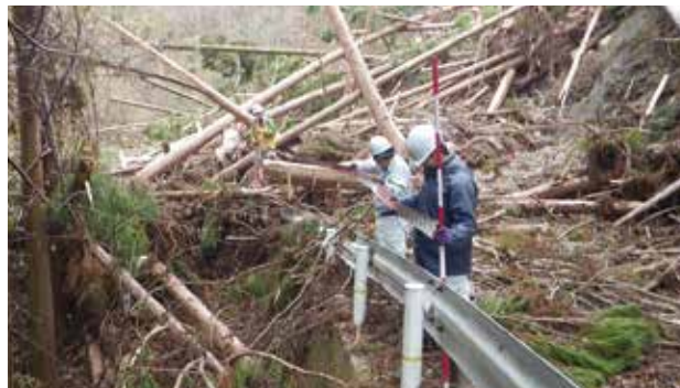
林道災害復旧の測量状況（仁淀川町 別枝）
