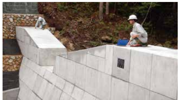
段階確認の様子
