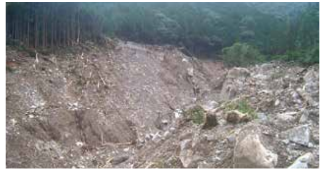
土石流により地山は深くえぐり取られ溪床には岩盤の露頭がみられる。林道が2カ所で流失
