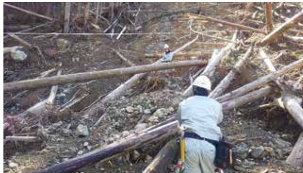
山地災害復旧の測量状況（仁淀川町 別枝）
