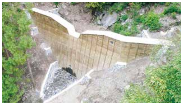
井崎林地荒廃防止工事 「森林土木工事木材使用設計（治山の部）」
