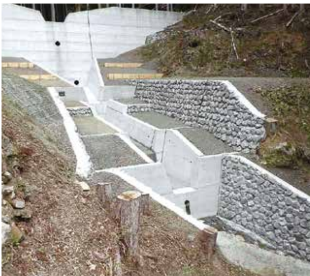
松谷林地荒廃防止工事 「森林土木優良工事（治山の部）」
