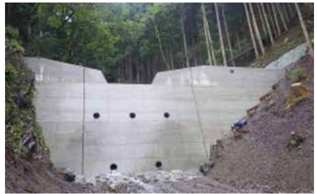
完成間近の現場です
