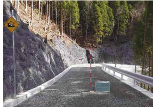
寒風大座礼東線1工区工事 「森林土木優良工事（林道の部）」
