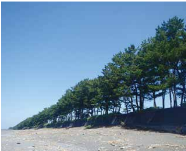
安田町唐浜 防潮堤の工事をします
