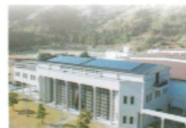
安芸工場の太陽光発電システム Solar Energy System (Aki Plant)
