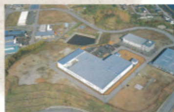
南国工場完成(2004年8月) Nankoku Plant Completed (August 2004)
