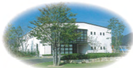
回路基板 (FPC) 工場 Electronic Devices Factory
