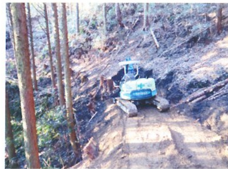
<(図-3) 作業道開設>
