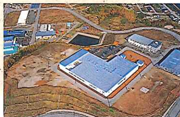
南国工場完成(2004年8月) Nankoku Plant Completed (August 2004)
