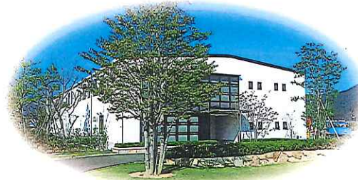
回路基板 (FPC) 工場 Electronic Devices Factory
