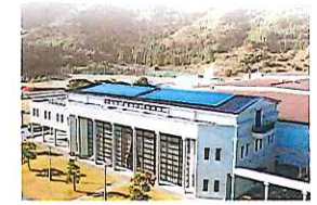
安芸工場の太陽光発電システム Solar Energy System (Aki Plant)
