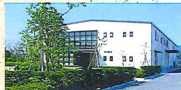
回路基板(FPC)工場建設(2000年6月) New Electronic devices factory (FPC production) completed (June 2000)
