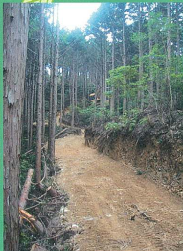
作業道開設状況
