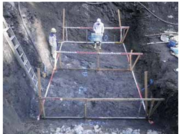
段階確認状況
