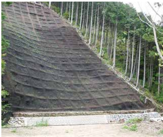
担当工事完成写真（中土佐町萩中）
