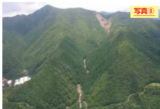
【大川村朝谷地内の山腹崩壊】
