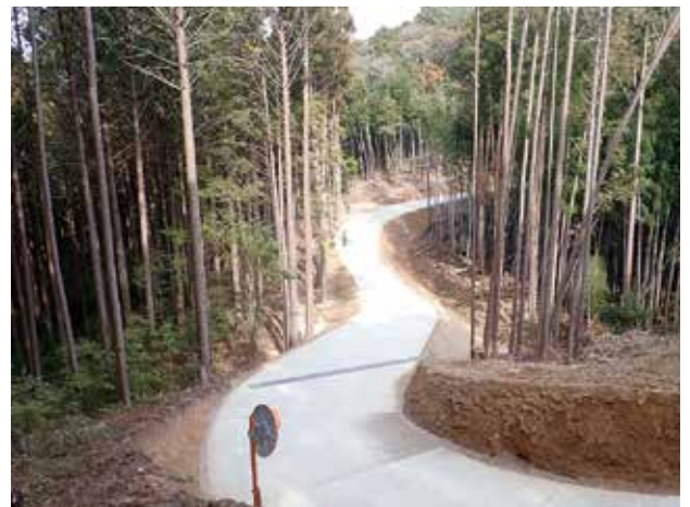
江川別役線 1 工区工事
