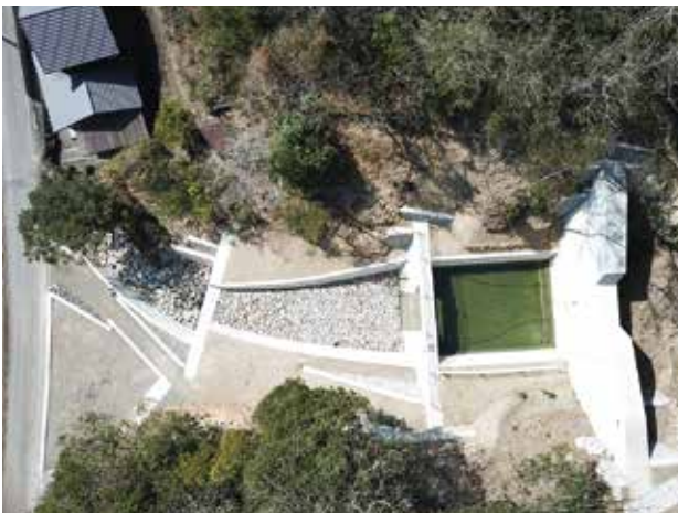
久保川 NO.2 林地荒廃防止工事
