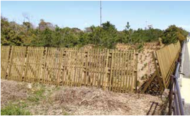
長浜防災林造成工事
