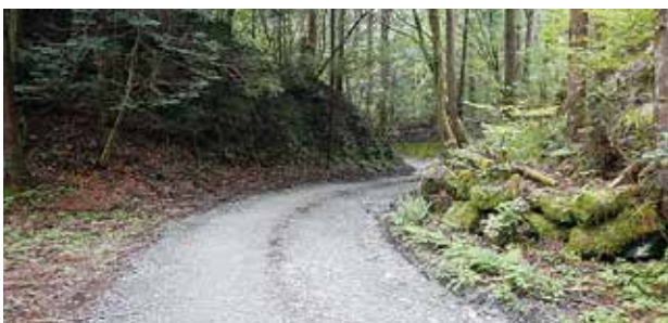
起点側国有林林道根須木線の状況
