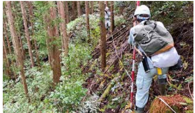
ハンドレベルによる予定施工基面高の杭設定状況
