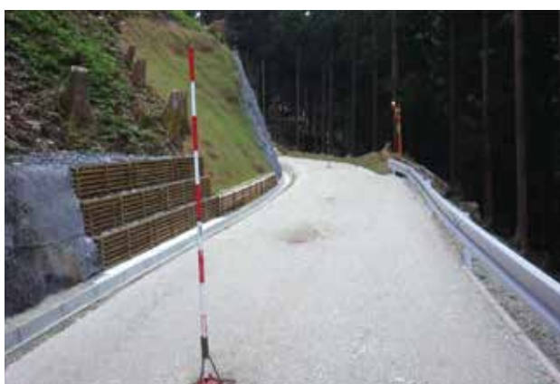
下土居松谷線1工区工事 (林道木材活用設計部門)
