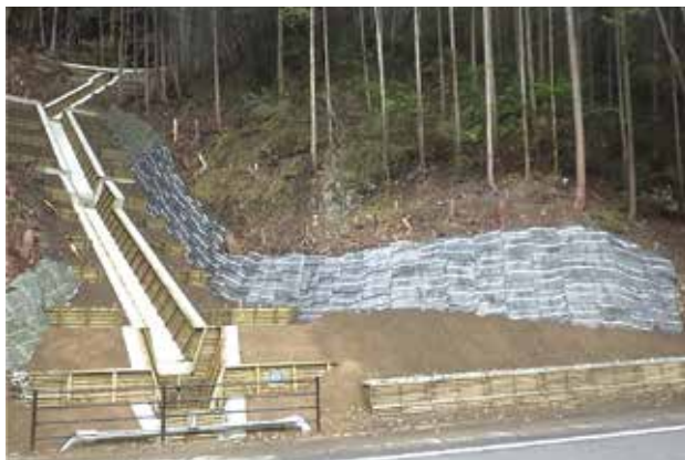
大正北の川林地荒廃防止工事 (治山木材活用設計部門)
