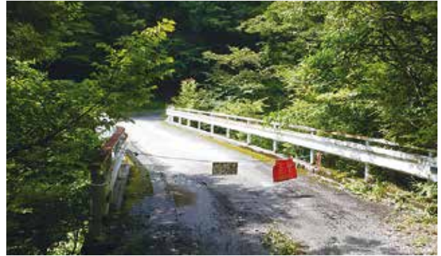
起点側 既設国有林林道の鋼橋 (L=28m)
