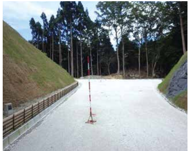
下土居桜谷線1工区工事（優良工事林道部門）
