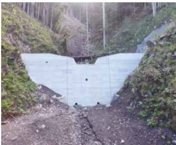
川口復旧治山工事の完成写真
