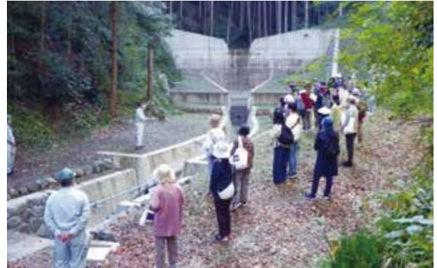
正尺治山現場
