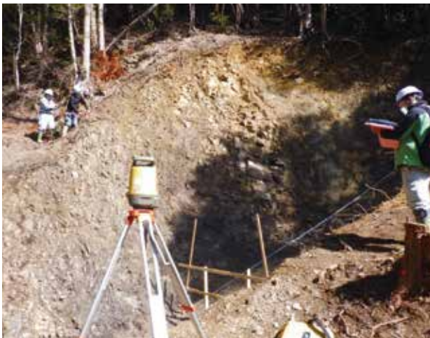
写真3 杭ナビによる現地検測
