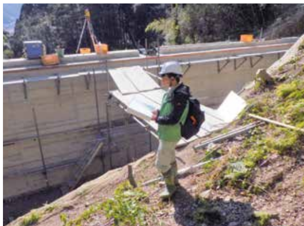
写真1 現地立会による段階確認の様子
