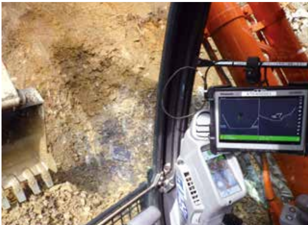
写真2 ICT 建設機械による掘削状況
