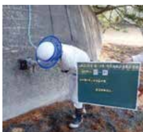
[鉄筋探查状況]
