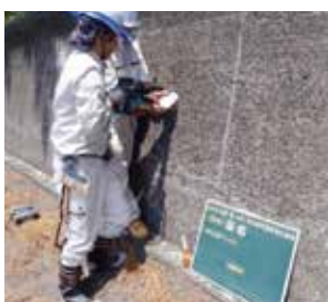
〔中性化深さ測定試験状況〕
