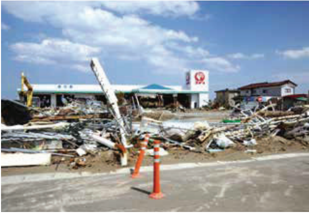
写真2 ホームセンター コメリ山元店。宮城県亙理郡山元町（2011年4月23日）。津波は地表から2mの高さで襲った。高知市も震災後に同様な光景が広がると考えられる。津波後、一帯では法律で新たな家を建てられなくなり、店も仙台南道路の山側に移転した。
