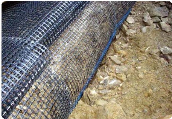
ジオグリッド背面巻き込み状況
