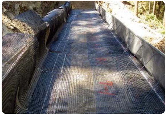
ジオグリッド敷設状況2
