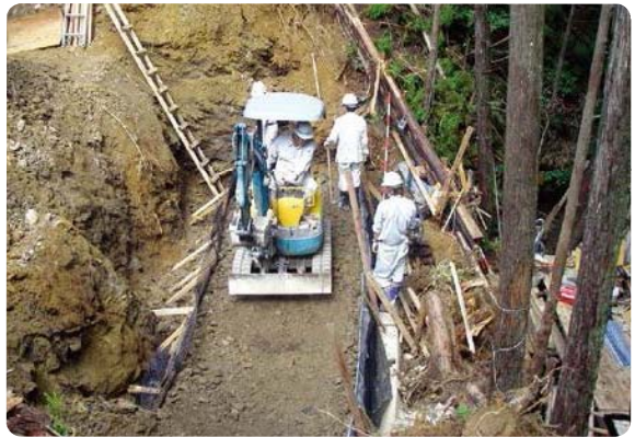
盛土材まき出し状況
