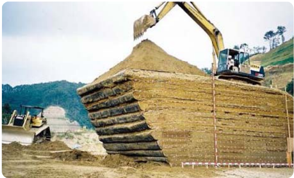
逆勾配盛土の構築実験(金沢大学らとの共同実験 1993年)
