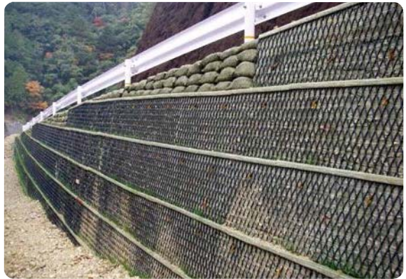
天端処理状況
