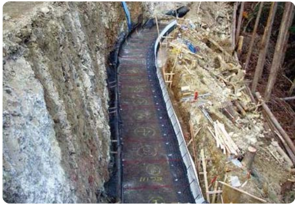
ジオグリッド敷設状況1
