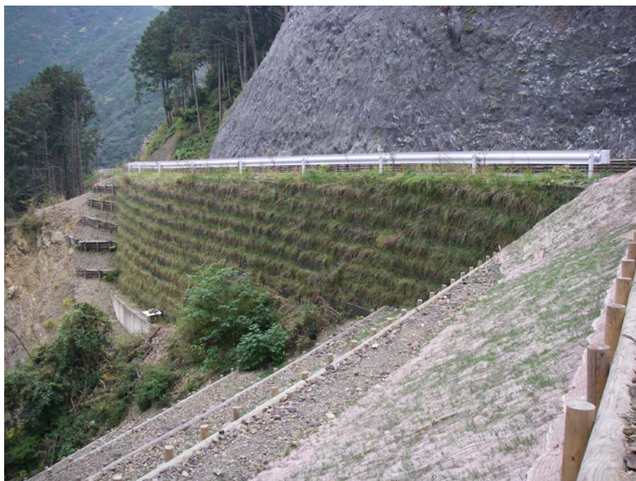
施工写真（全景）
