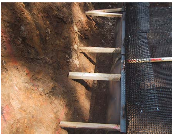
抜き型枠 施工例
