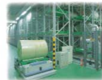
自動倉庫 Automatic Storage System
