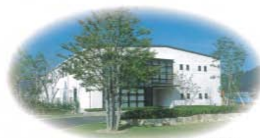
回路基板 (FPC) 工場 Electronic Devices Factory
